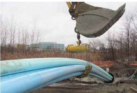
Boston, MA: 1,150 LF (6 x 8") Conduit
